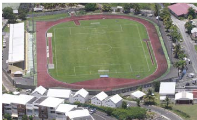
Le stade Roger Zami connaîtra très prochainement des travaux de réfection.
